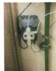
➤ **Serbatoio di accumulo e gruppo autoclave:** relativamente a questa parte dell'impianto, l'unica parte critica è il gruppo autoclave, ultimamente si è rotta la scheda elettronica e il fornitore ci ha comunicato che non dispone più delle parti di ricambio. L'intero sistema presenta un'usura abbastanza critica data dagli anni di funzionamento. Si consiglia la sostituzione dell'intero gruppo autoclave con un sistema di ultima generazione a frequenza variabile (Inverter).
